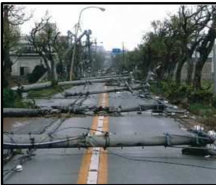
台風による電柱倒壊状況
