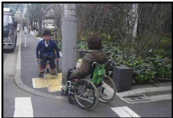
車いす通行の支障
