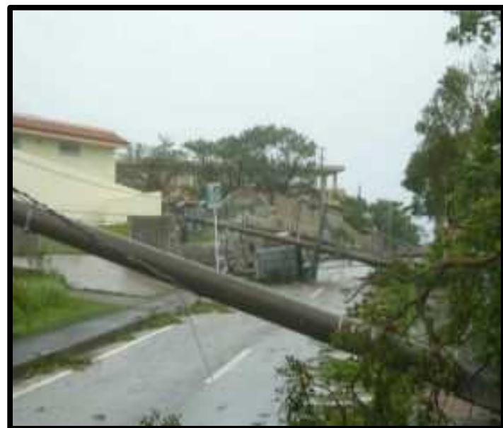
台風による電柱倒壊状況
